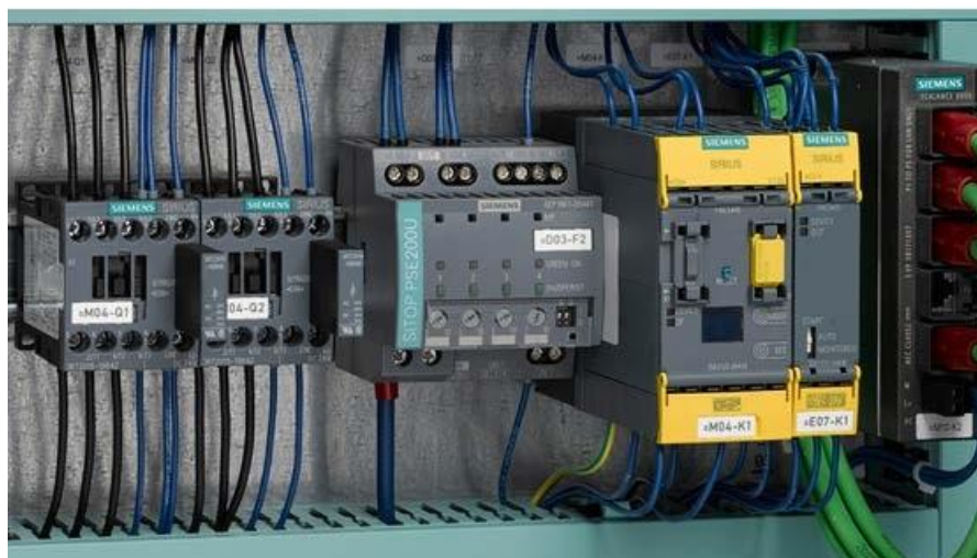
Gráfico 6-61 Ejemplo: Designaciones de referencia sobre varios elementos del equipo en el panel de control
