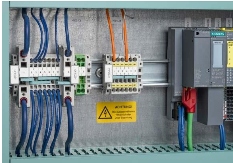
Gráfico 6-64 Ejemplo: Marcado de terminales
