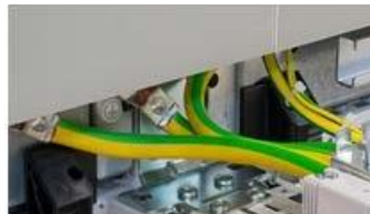
Gráfico 6-48 Ejemplo: Conductor protector con aislamiento VERDE Y AMARILLO
