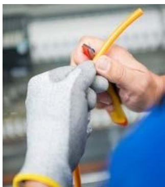
Gráfico 6-23 Eliminación del aislamiento del cable por destrucción
