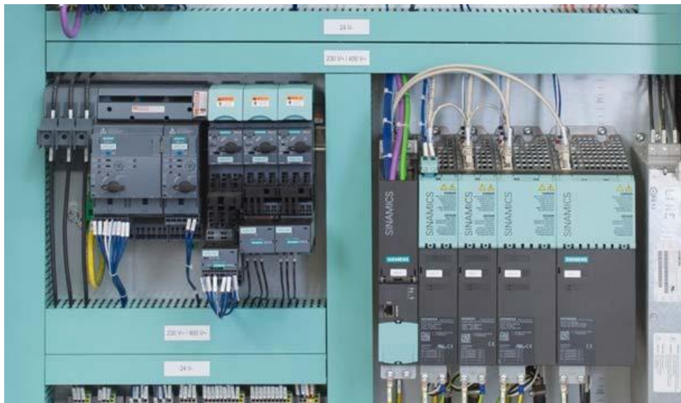
Gráfico 6-65 Ejemplo: Enrutamiento separado de circuitos de 24 V y 230 V/400 V
