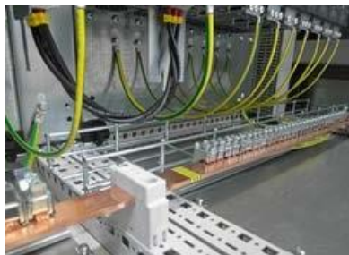
Gráfico 6-68 Ejemplo: Marcado con VERDE Y AMARILLO al final de la barra colectora del conductor protector
