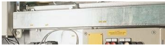
Gráfico 6-25 Cable instalado libremente en un conducto para cables
