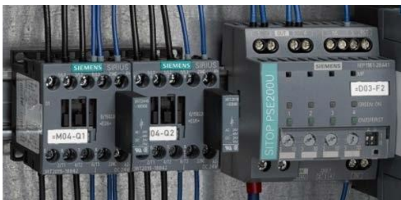
Gráfico 6-63 Ejemplo: Uso del manguito terminal en los puntos de sujeción en el equipo
