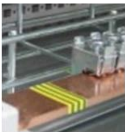
Gráfico 6-50 Ejemplo: Combinación bicolor VERDE Y AMARILLO al final de la barra puesta a tierra
