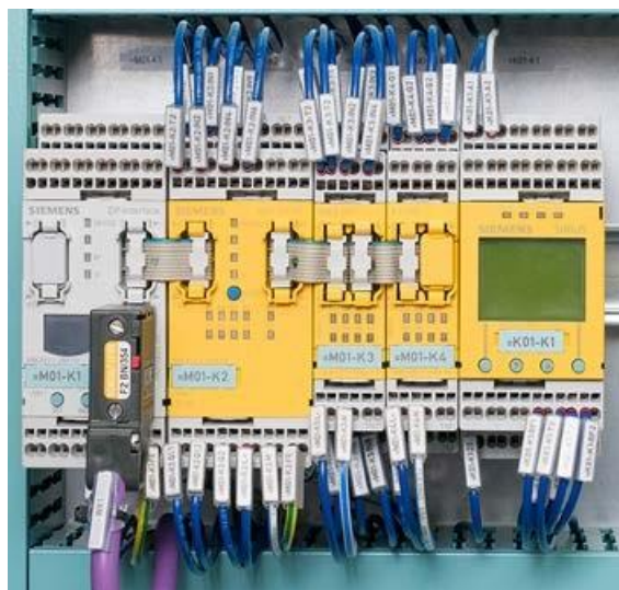
Gráfico 6-66 Ejemplo: Identificación de cables y equipos individuales
